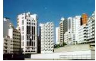
(شكل 4) يوضح بعض المباني الموجودة بالقرب من الحرم الشريف بمكة وقد تم بناؤها بأساليب بعيدة عن الطابع التاريخي أو التراثي ومعالجات للوجهاً والفتحات غريبة عن الطراز الإسلامي.
