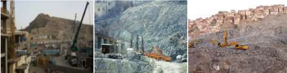
(شكل 6) يوضح أثناء إزالة المباني من جبل عمر تمهيدا لإزالة الجبل والجبال المجاورة للحرم الشريف للتوسعة الحالية.
